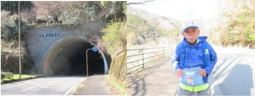
※川平トンネル
